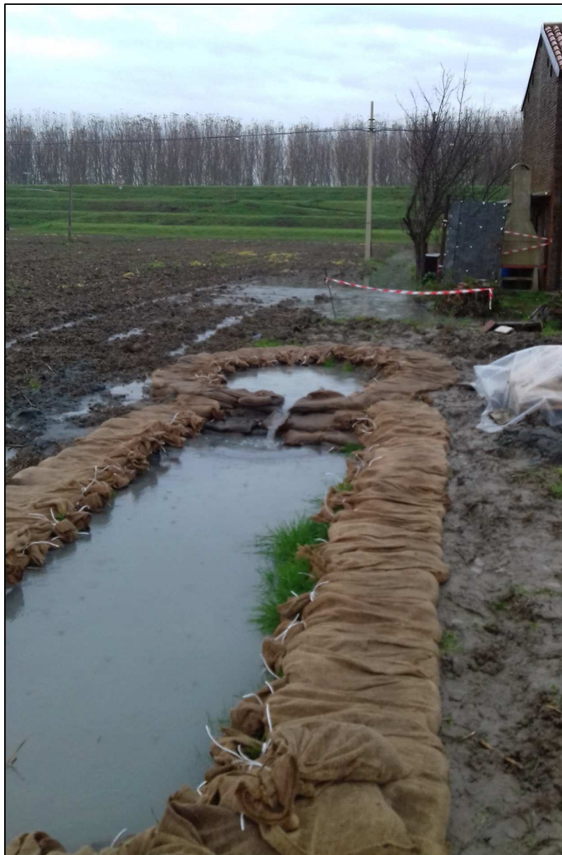
Figura 5 - Località Mazzorno sinistro tra stanti 515-516 (Casa Roncon) – Novembre 2019 - coronella di sacchi impostata a livello del p.c. nelle vicinanze di un edificio di civile abitazione
